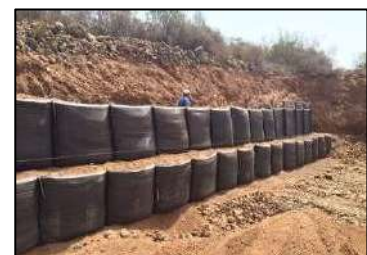
Muros de gravedad gaviones flexibles
