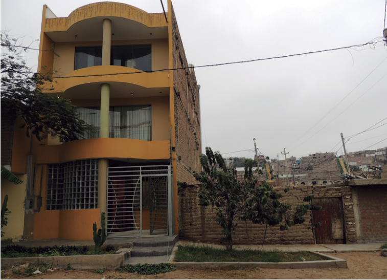
El Porvenir: Sector Río Seco I
