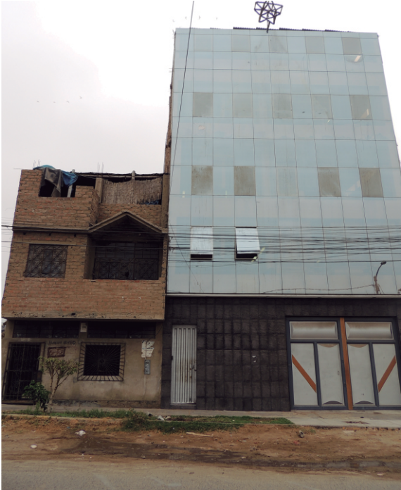
El Porvenir: Sector Río Seco I
