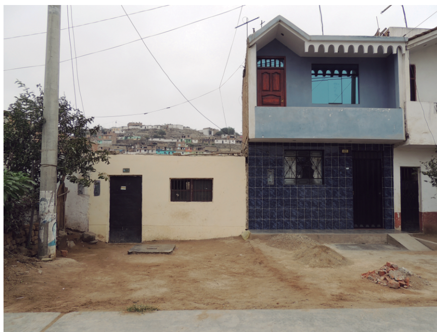
El Porvenir: Sector Río Seco I
